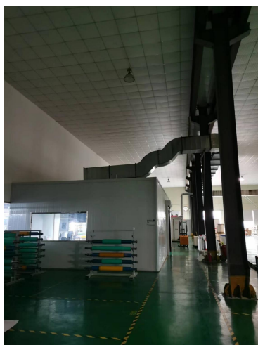
密闭的熟化室及废气收集口
