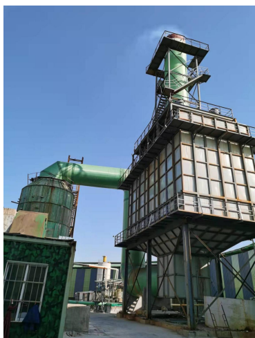
焙烧废气处理设施脱硫塔
